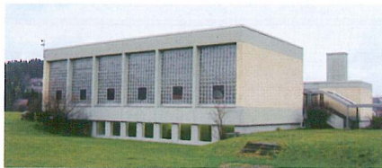
Die Sporthalle in Trochtelfingen – vor und nach dem Umbau.
