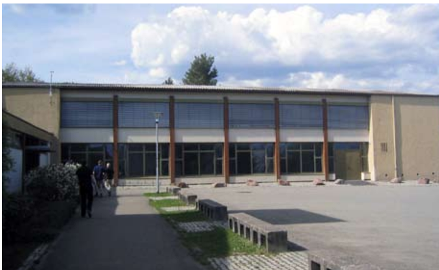
An der Südseite der Halle entstehen neue Umkleide- und Lagerräume. Links der Eingang zur kleinen Schwimmhalle.
